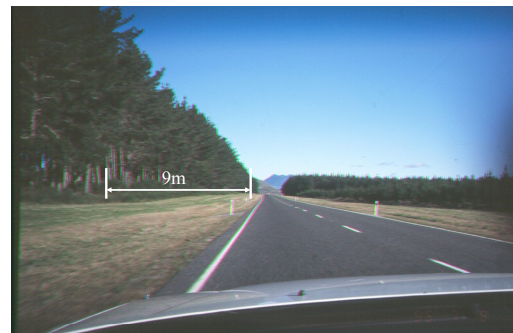
図-11 クリアゾーンと植栽を活用した安全で景観のよい道路空間形成の取り組み
