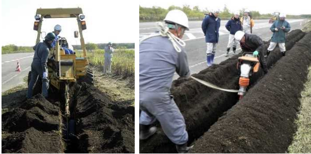
写真-4.6 掘削土の堆積状況
