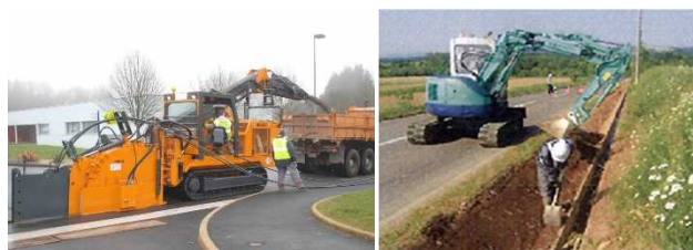
写真-4.1 左：海外における専用機械による施工例 ウェブページより引用 10) 右：国内における油圧ショベルによる施工例 北海道内自治体提供
