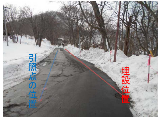
写真-3.9 浅層埋設箇所と引照点（2019.2.15）
