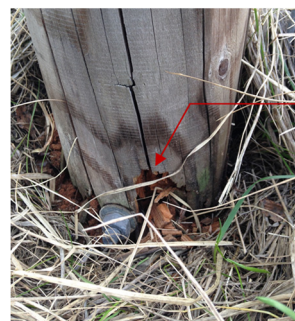
写真-3 柱部材の地際部の腐朽劣化の一例
