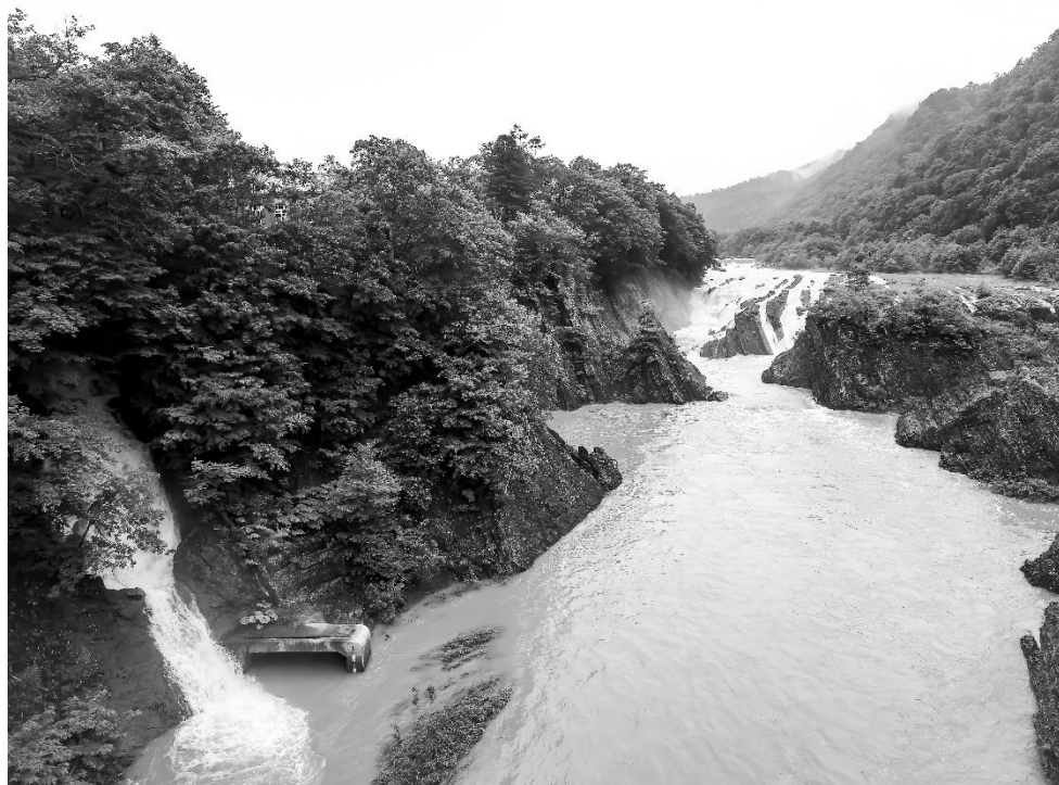
写真2 千鳥ヶ滝。樹木の向こうに発電所建屋（写真中央左）。千鳥ヶ滝の奥に取水堰（写真右上）、コンクリート構造の放水口（写真左下）。手前の小さな滝は滝の上公園内を横切る小川の合流。発電所が稼働していない場合は、写真中央付近にある余水吐の放水口から4つめの滝を見ることができる。
