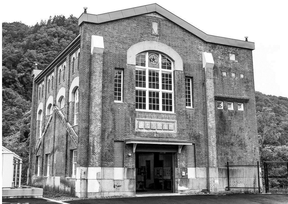
写真1 滝の上発電所建屋。戦時中には爆撃から守るために煉瓦造の建物をコールタールで黒塗りしていた名残りが煉瓦壁面に残る。2階部分には高圧送電線を通すための穴が開けられていた。壁面耐力の補強のため、改修工事時に一部の開口部はふさがれている。
